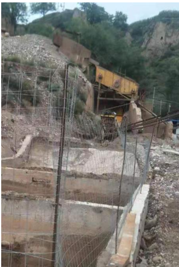
验收时沉淀池进水渠道
