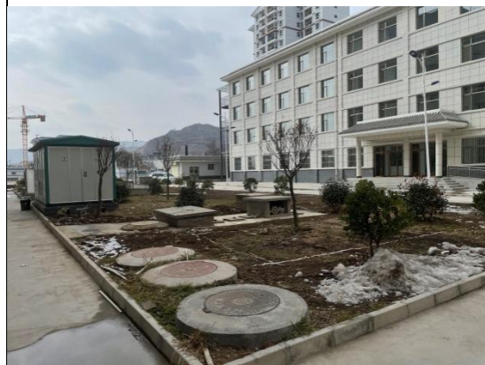
地埋式污水处理站
