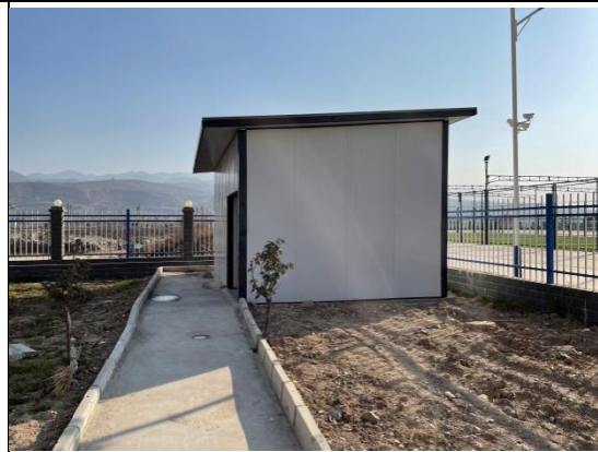
医疗废物暂存间
