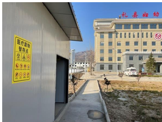
医疗废物暂存间
