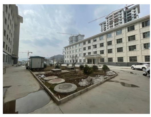
污水处理站周边绿化
